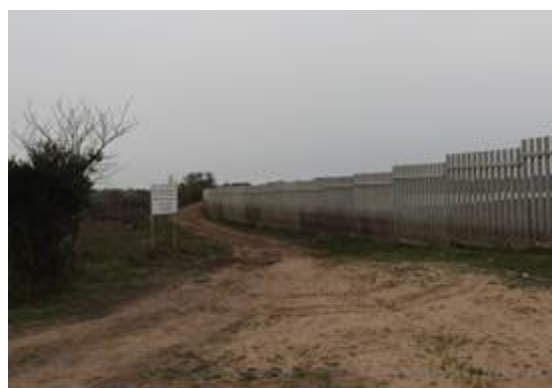
Figura 6. Gradil construído no limite oeste da REBIO
