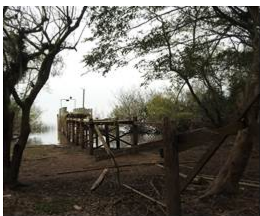
Figura 3. Trapiche avariado pela enchente.
