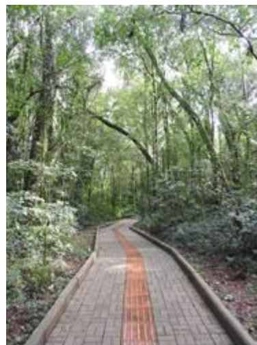
Imagem 04: trilha principal com bloco intertravado e acessibilidade para PCD.
