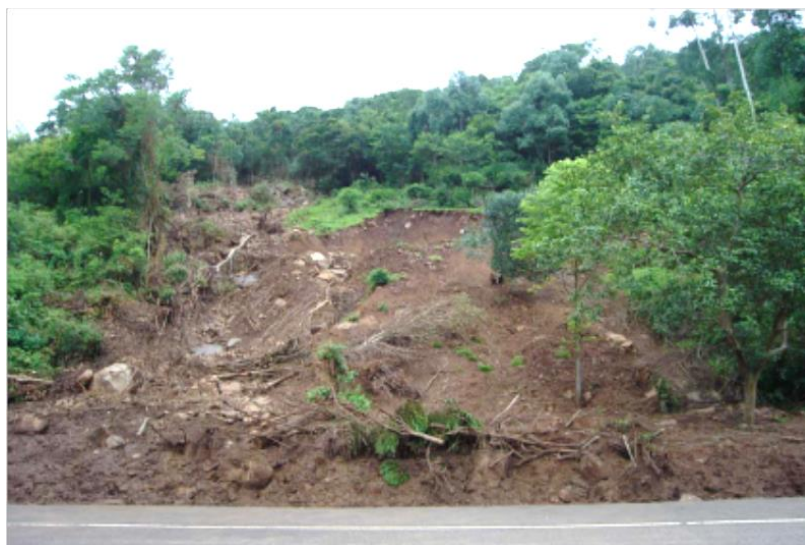
Figura 4: Movimento de massa (escorregamento rotacional) junto ao eixo da RS 486. Março de 2007.
