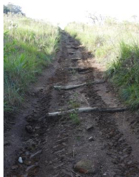
Imagem 4: trilha com contenções para frear a erosão.
