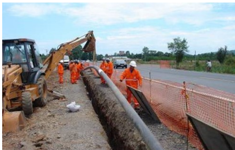
Figura 7 - Exemplo de lançamento de tubulação por abertura de vala
