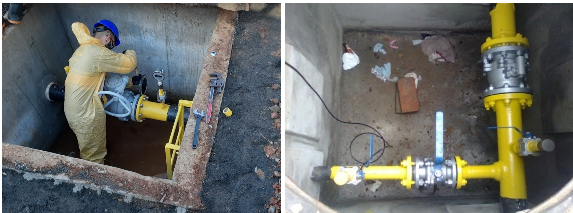
Figura 31 - Válvulas de bloqueio de tubulação de aço
