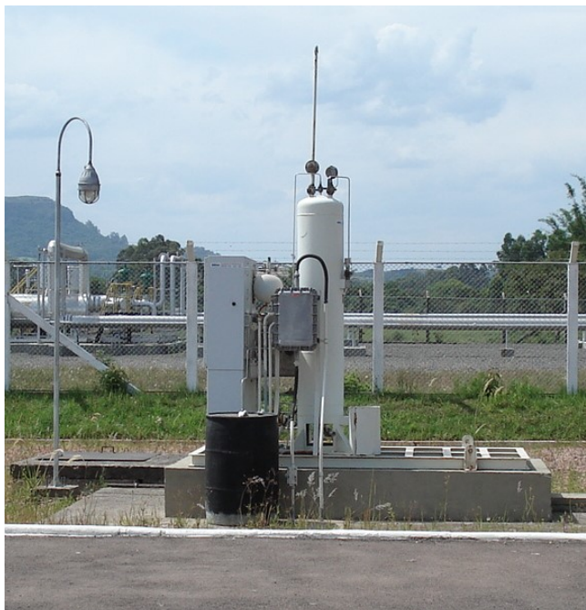
Figura 14 - Foto de equipamento odorizador utilizado pela Sulgás
