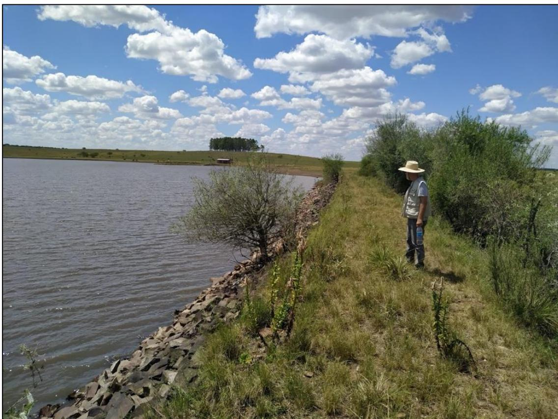
Figura 10: Barragem com presença de vegetação nos taludes.
