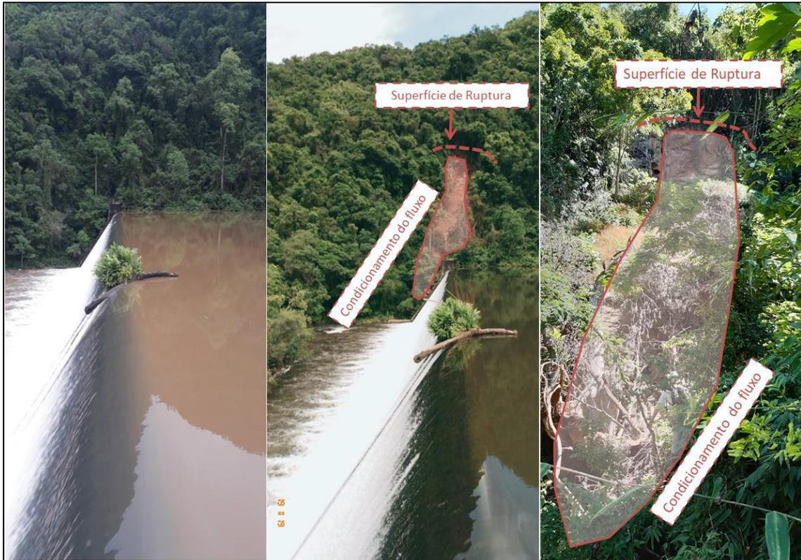
Figura 14: Delimitação do fluxo de detritos a partir da superfície de ruptura e do plano de falha. Da esquerda para direita, temos as fotos em ordem cronológica 31/10/19, 19/11/19 e 05/03/20. Extraído do relatório de campo produzido pelos técnicos do GT.
