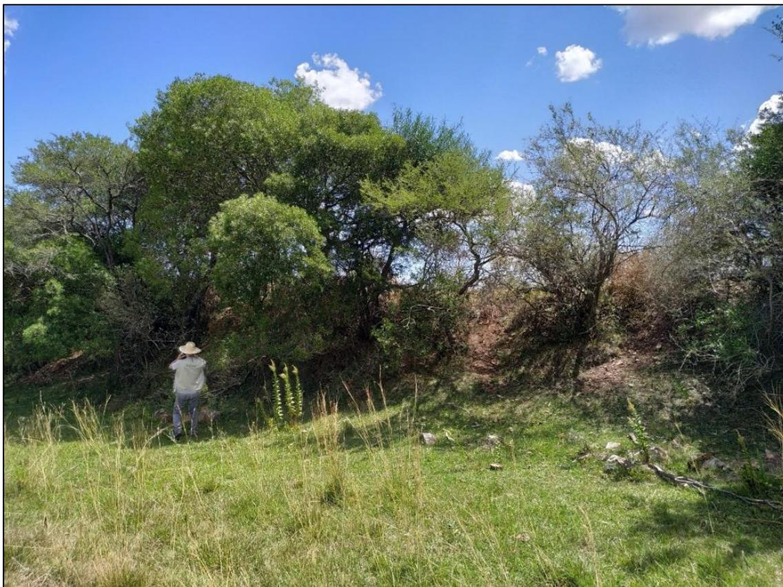
Figura 11: Talude de jusante com intensa presença de vegetação.
