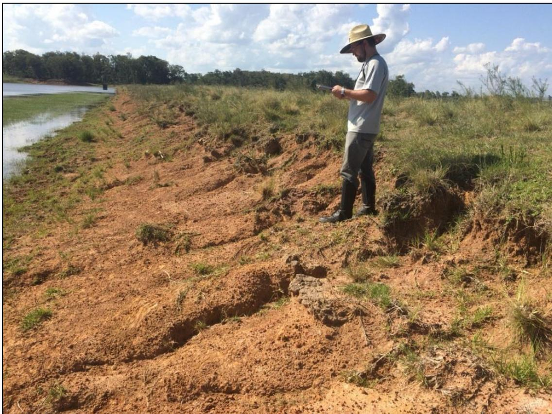
Figura 9: Barragem com falta de enrocamento e erosões no talude de montante.
