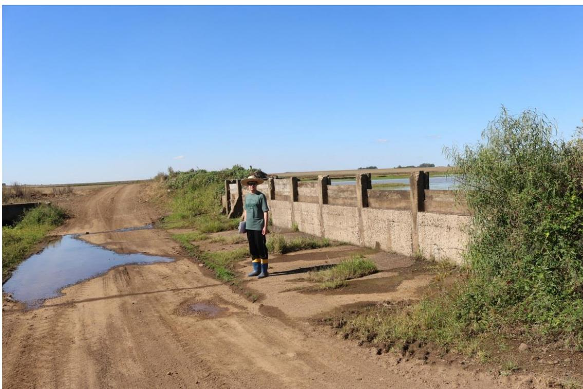
Figura 29: Exemplo de vertedouro comum em barragens de terra, com comporta para controlar a vazão de saída d'água.
