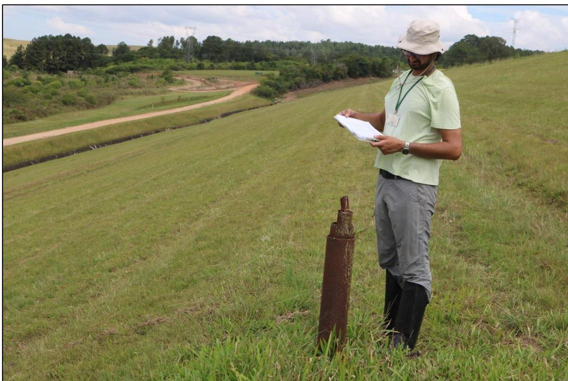
**Figura 13: Barragem de terra com talude de jusante revestido com vegetação rasteira e com adequada manutenção.**
