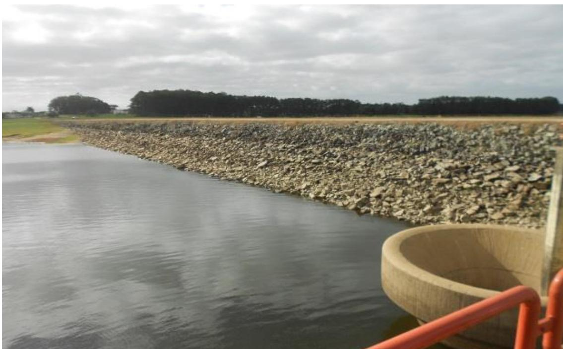
Figura 2: Barragem de terra com talude de montante revestido de enrocamento.
