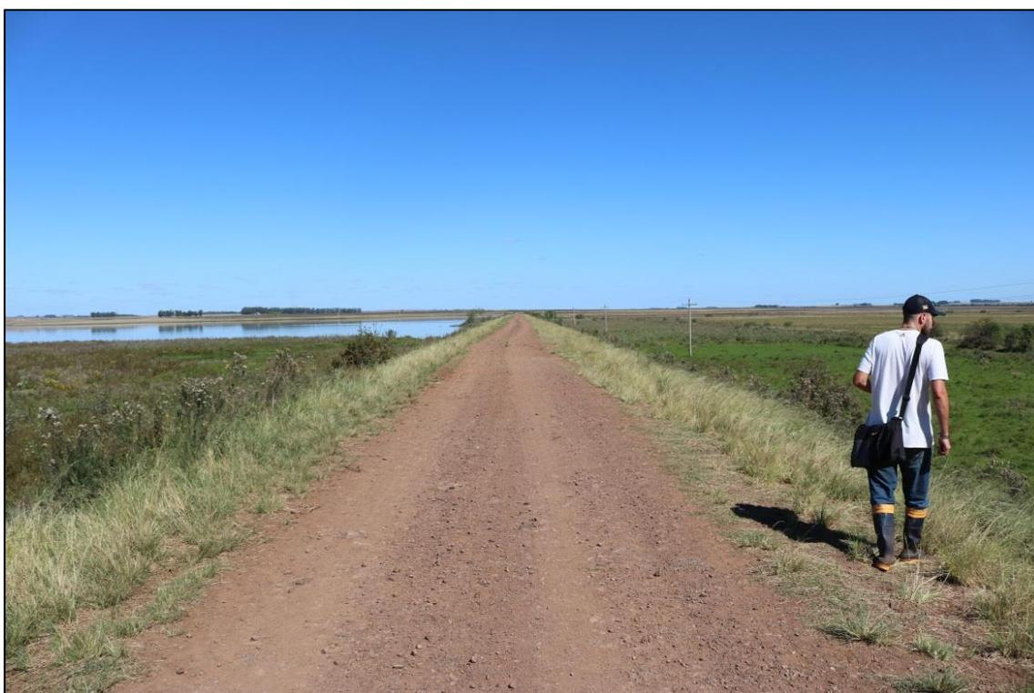
**Figura 20: Crista da barragem de terra sem anomalias aparentes.**
