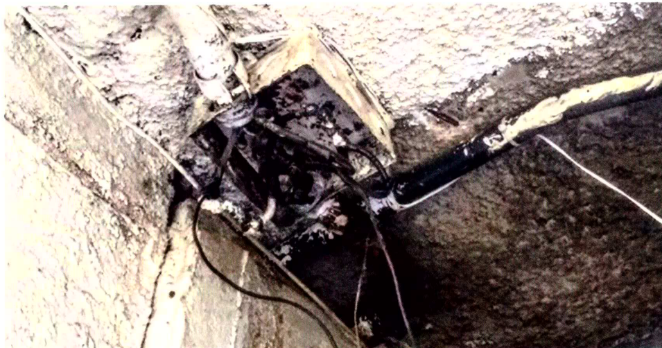
Caixa de passagem e conexões no corredor próximo a antiga sala de Recursos Humanos. Crédito: Jaqueline Käfer
