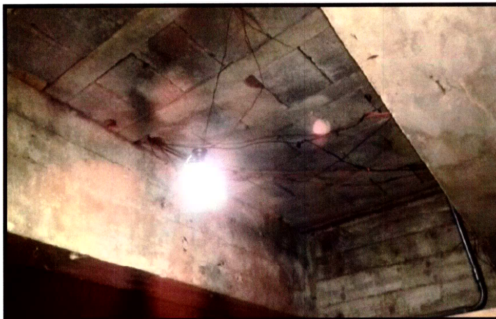
Outra vista do circuito externo sem proteção adequada que atende ao vestiário do subsolo. Crédito: Jaqueline Käfer
