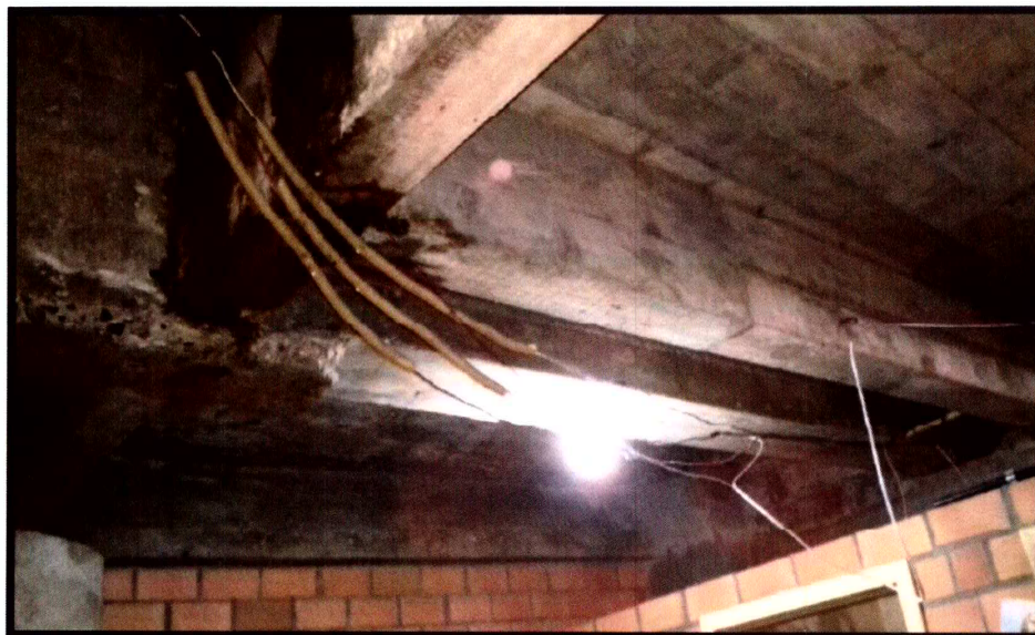
Vista do circuito externo sem proteção adequada que atende ao vestiário do subsolo. O problema é agravado pela infiltração de água. Crédito: Jaqueline Käfer
