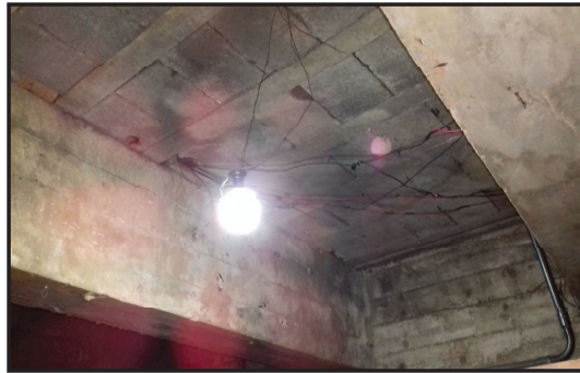
Imagem 04: Vestiário subsolo – Fiação sem a devida proteção
