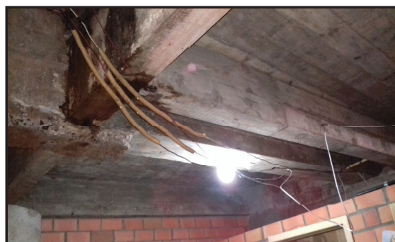
Imagem 03: Vestiário subsolo – Fiação sem a devida proteção exposta a umidade
