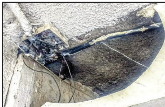
Imagem 02: Corredor próximo a antiga sala de RH
