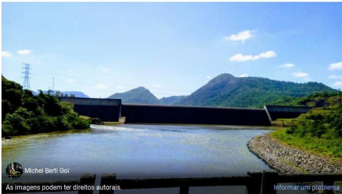
Subestação Dona Francisca
