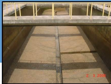
Lodo dos Decantadores
