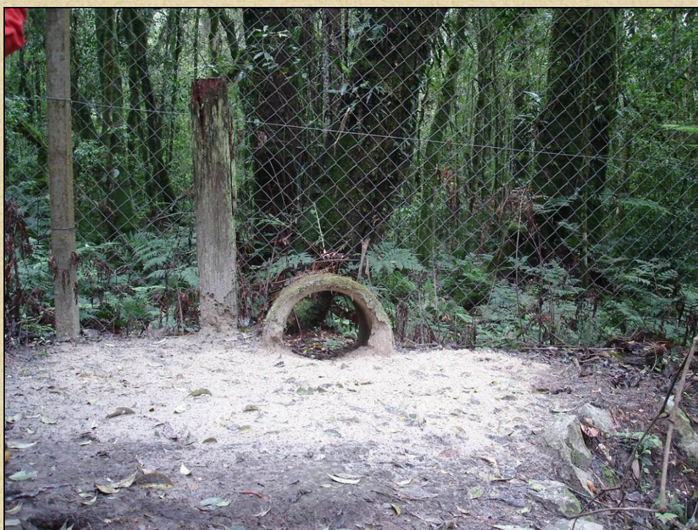
Fotografia 51. Tubulação de concreto que interrompe o cercamento da área, para propiciar livre trânsito da fauna, entre as áreas verdes do Condomínio O Bosque e as áreas verdes lindeiras.
