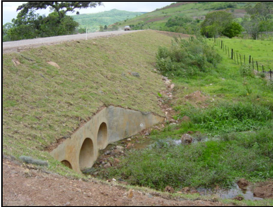
Figura 3.1 Canaletas de bueiros e galerias sob a rodovia.
