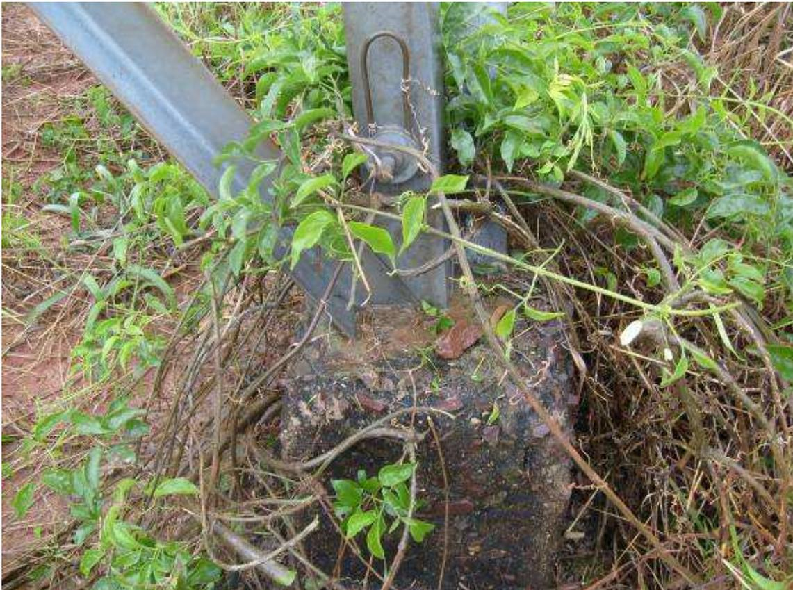
Imagem de um bloco de concreto da base da torre.
